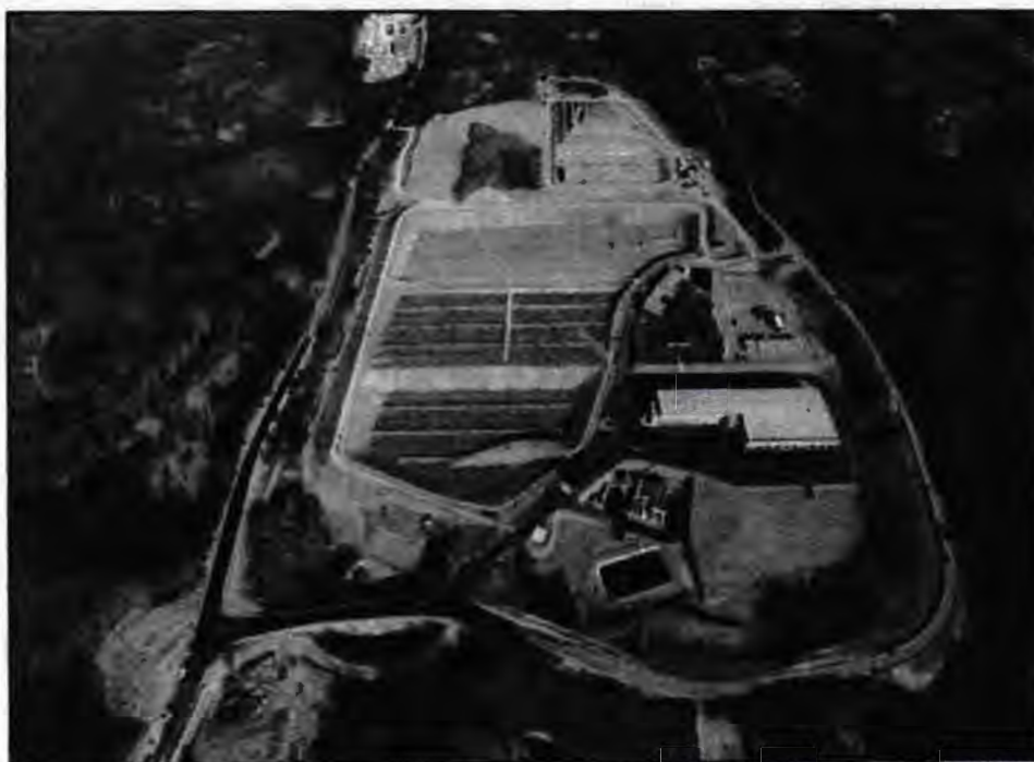
Slika 11. Postrojenje mehaničko-biološke obrade u ŽCGO Marišćina (izvor: http://www.ekoplus.hr )
